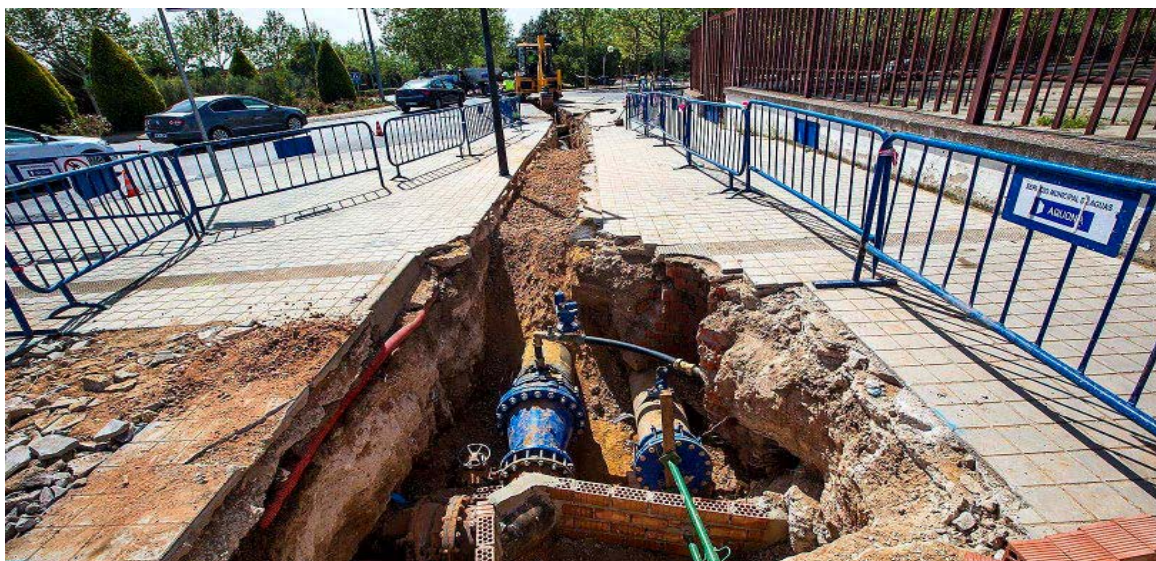
Imagen de unas obras realizadas para la mejora de la red de abastecimiento en la capital. / RUEDA VILLAVEDE
